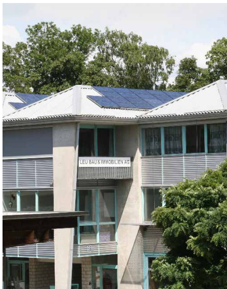
Blick auf einen Teil der bestehenden Photovoltaikinstallation auf dem Dach des Gewerbehauuses Stöckmatten
